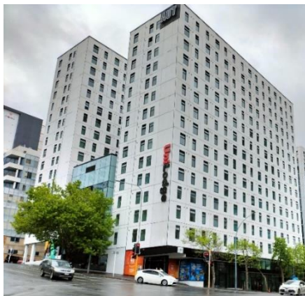
＜オークランド工科大学学生寮の外観＞
